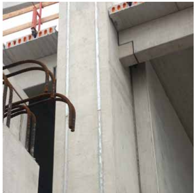
Vertikale HTU Schiene zur Befestigung der Fassadenbekleidung
