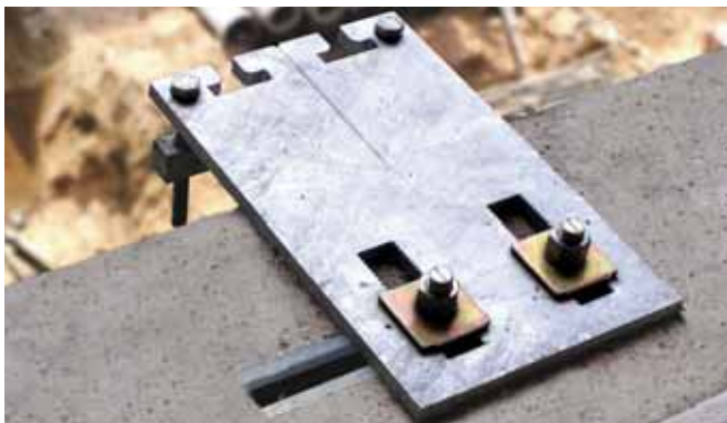
Typische Curtain Wall Befestigung an HTA-CE Ankerschienen
