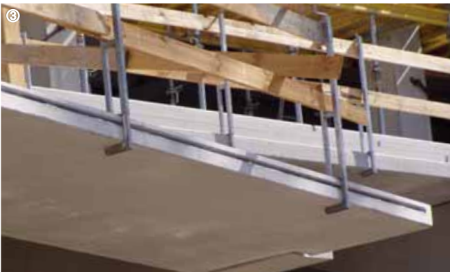
①-④: Befestigung von Geländern, Multifunktionshalle/Berlin
