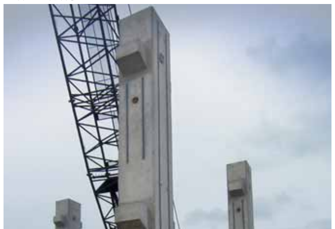
Vertikale Schienen für Anbauteile an Stützen
