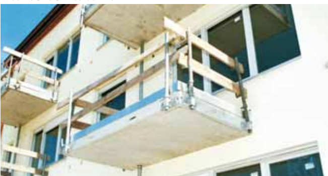
HGB schon während der Bauphase zur Absturzsicherung genutzt
