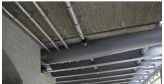
Befestigung von Entwässerungsleitungen
