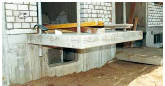
Fertig einbetonierte HGB-Schiene, Wohnungsbau
