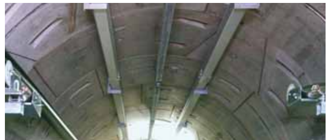
Gebogene Halfenschienen in Tübbing-Elementen
