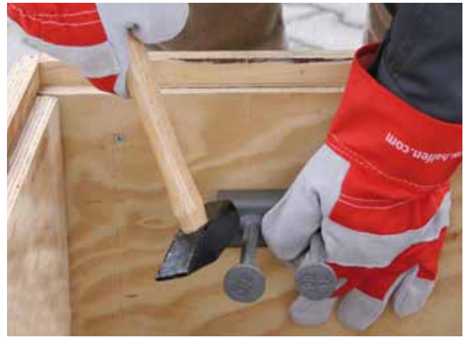
Halfenschienen an die Schalung annageln
