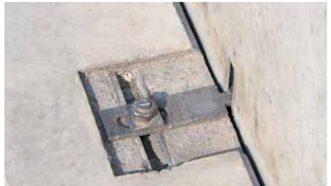
HALFEN Verankerungslasche HKZ mit gezahnter Gegenplatte
