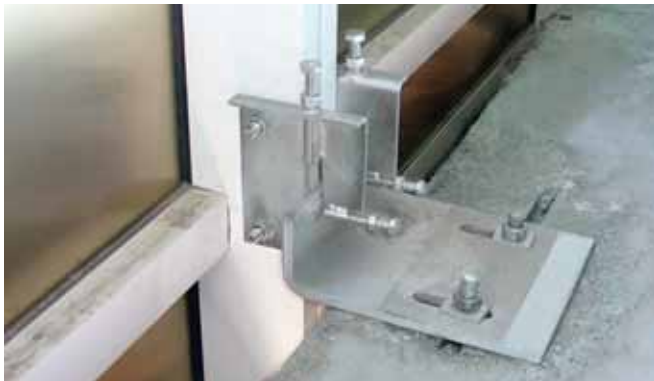
Befestigung einer Element-Fassade mittels HCW-B2 Brackets an HTA-CE Ankerschienen
