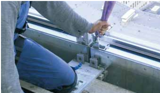
Befestigung einer Element-Fassade mittels Bracket an HTA-CE Ankerschienen
