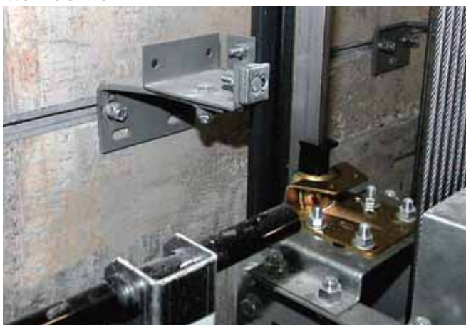
Befestigung von Führungsschienen
