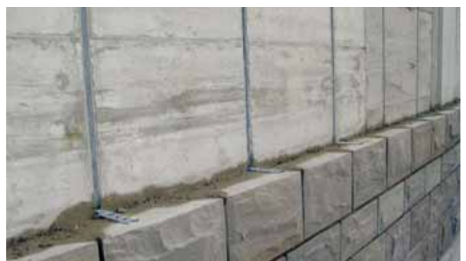
Maueranschluss mit HALFEN ML
