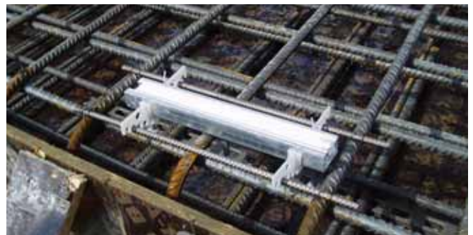
Befestigung mit HALFEN ChanClip (siehe → 2.2.2)
