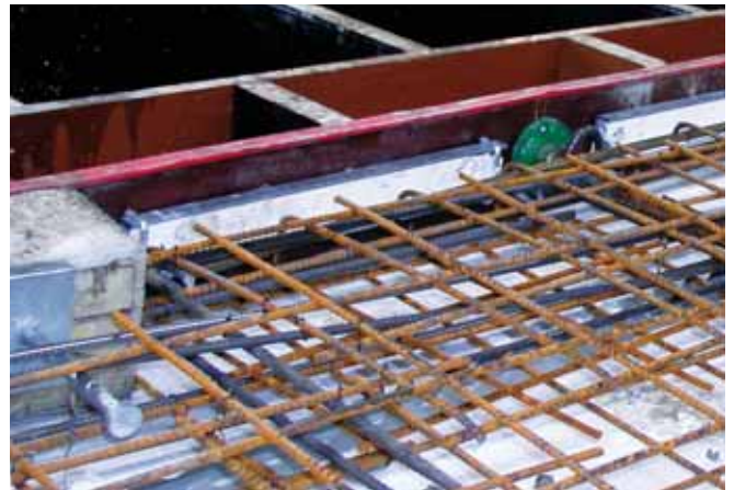
Einbau der HTU Schiene in Stirnseite der Betondecke
