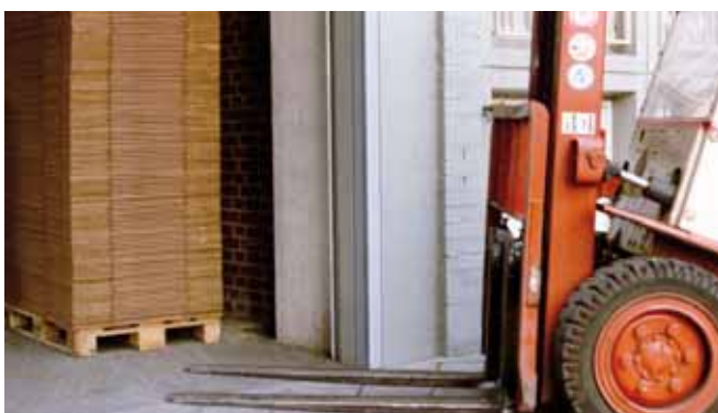
Kantenschutzwinkel an Wandecken in einem Industriegebäude
